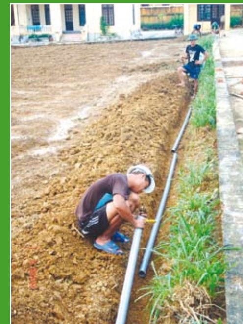
Nối đường ống chính
