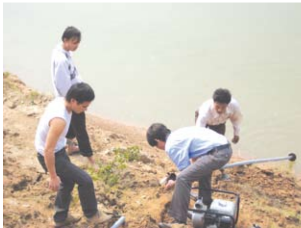
Đặt máy bơm gần nguồn nước
