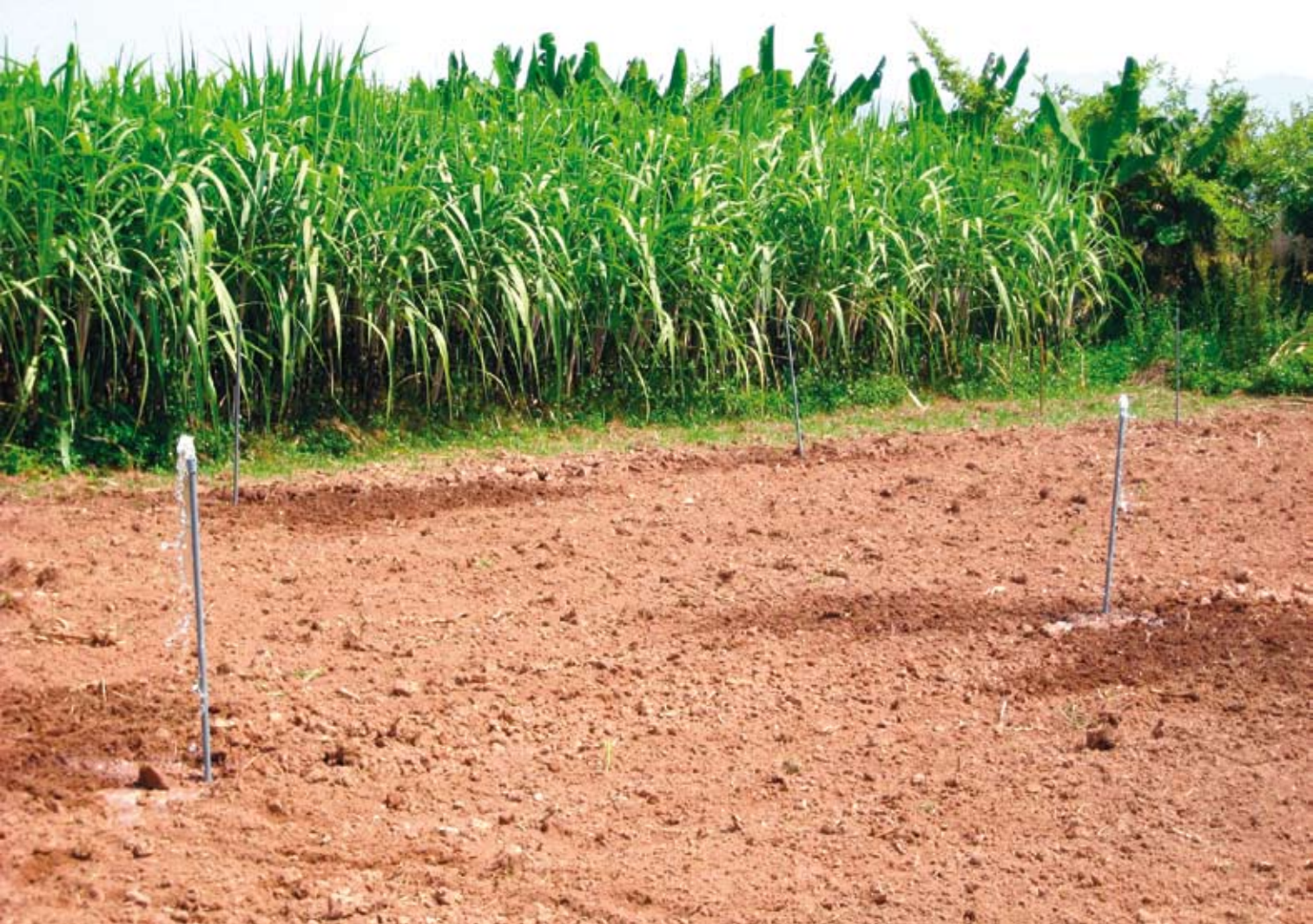
Rửa hệ thống đường ống dưới đất trước khi lắp đặt tép phun
