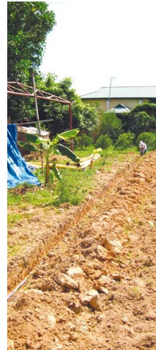
Đào rãnh lắp đặt đường ống chính
