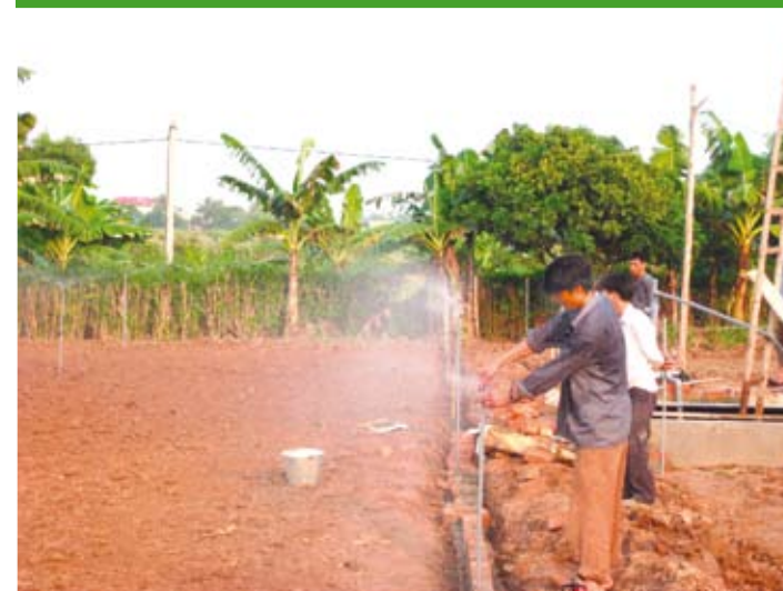
Cột, tép phun nước và chắn nước
