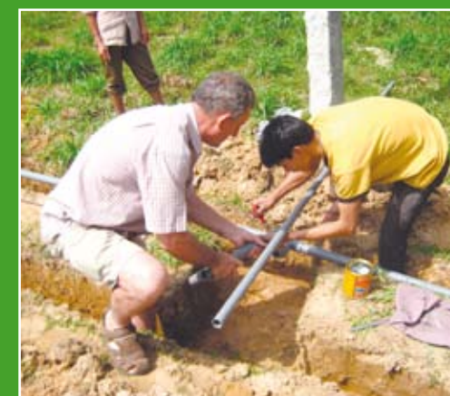
Cắt đường ống chính để nối đường ống phụ
